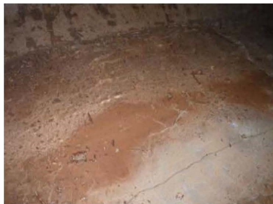
Fotografia 5. Fissures interiors
