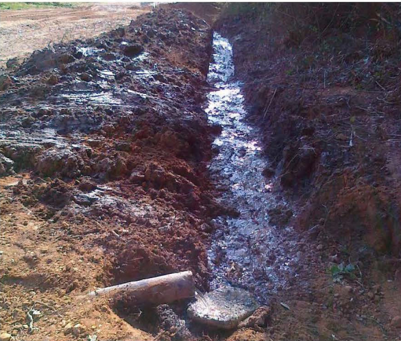
Fotografia 10. Filtracions d'aigua constants del dipòsit
