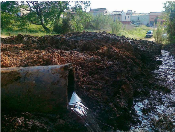
Fotografia 9. Filtracions d'aigua constants del dipòsit
