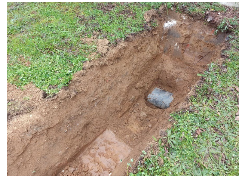
Figura 5. Connexió de la nova canonada a la canonada existent de FD DN300
